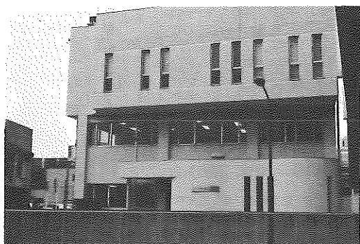
写真2 豊橋乾繭取引所 駅前大通2丁目。1983年7月21日撮影。
