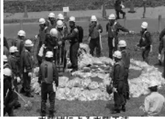
水防団による水防工法 (釜殺工)
