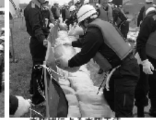
水防団による水防工法 (改良積み土の工)
