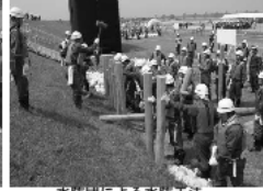
水防団による水防工法 (杭打ち積み土の工)
