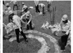
大学生による水防工法 (月輪工)
