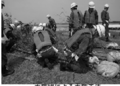
水防団による水防工法 (竹流し工)
