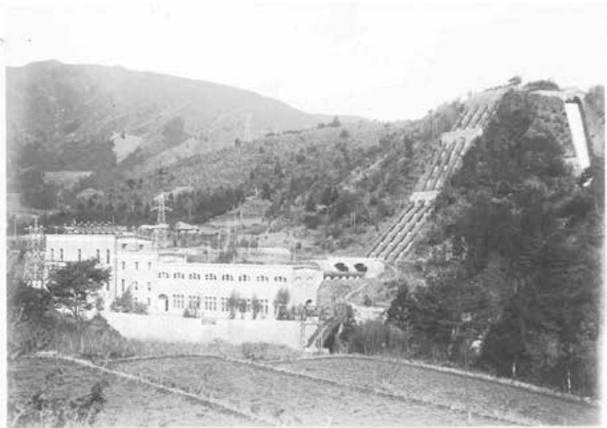
東横山発電所
