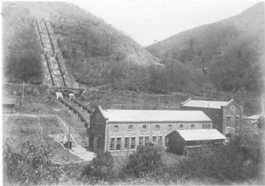
西横山発電所
