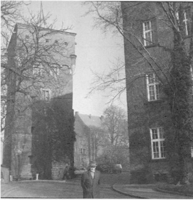
(写真 20/武)〔註〕 向かって左側が監獄塔 (1977 年秋撮影)
